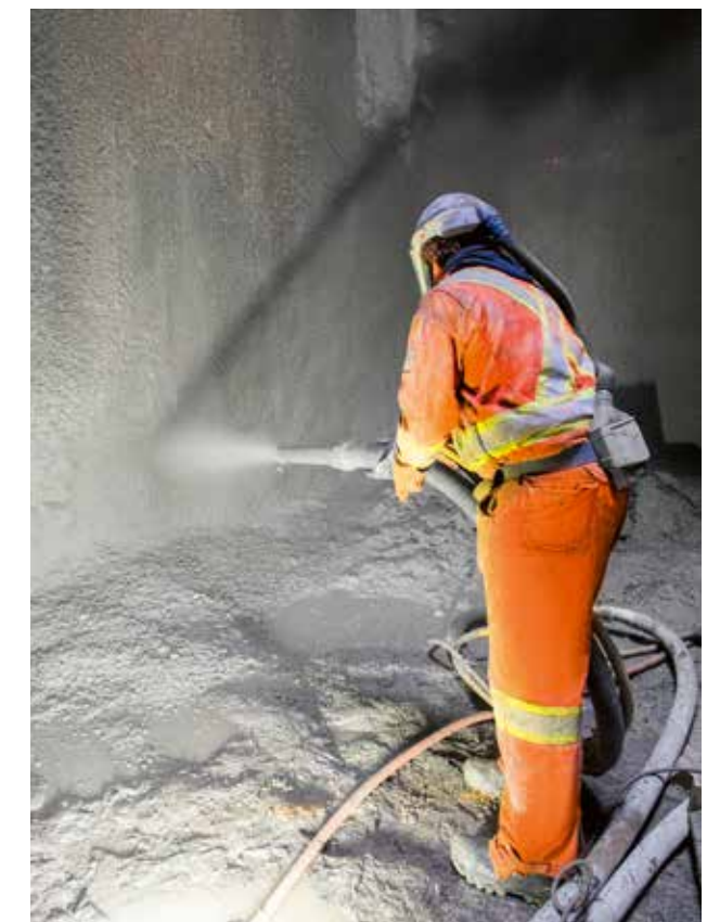
Im Zentrum Montreals wird die neue Stadtbahn zu einem grossen Teil in den Untergrund gebaut. Die Tunnelwände werden nach dem Ausbrechen mit Sika Spritzmörtel stabilisiert.
