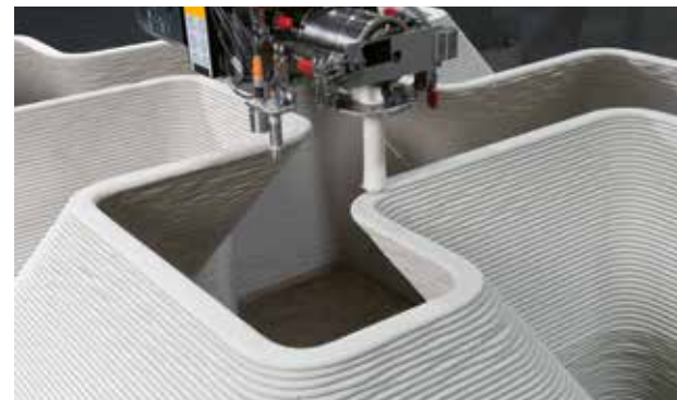
Im patentierten Druckkopf, den Sika für den 3D-Betondruck entwickelt hat, wird der Mörtel mit verschiedenen Additiven vermischt. Er verbindet sich innerhalb von Sekunden mit der zuvor aufgetragenen Betonschicht.
