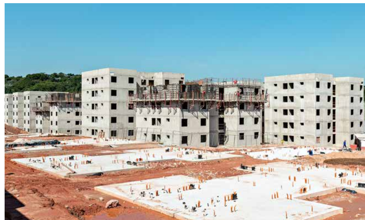
Ein Bauprojekt von Direcional Engenharia umfasst im Schnitt über tausend Wohneinheiten. Die Bauzeit für einen Wohnblock beträgt 45 Tage, den Innenausbau eingerechnet.
