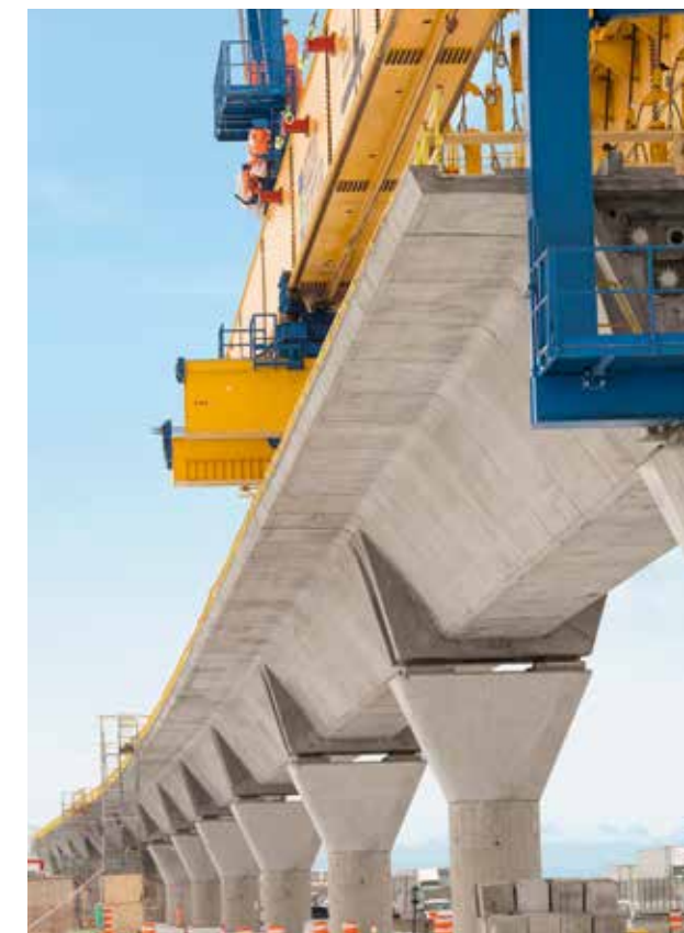
Über ein Drittel der Metro verläuft als Hochbahn auf Pfeilern. Mithilfe hochleistungsfähiger Sika Strukturklebstoffe werden die Betonelemente zusammengefügt.
