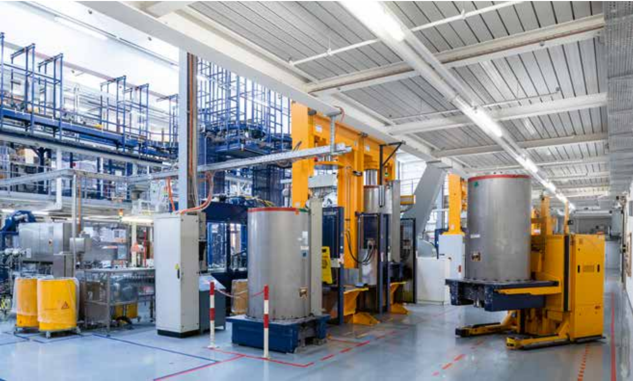
Die Klebstoffproduktion im Sika Werk Düringen in der Schweiz ist vollständig automatisiert – von der Bereitstellung der Ausgangsstoffe über die Produktion und das Abfüllen des fertigen Endprodukts in Kartuschen, bis hin zur Verpackung und Palettisierung der Kartuschen.
