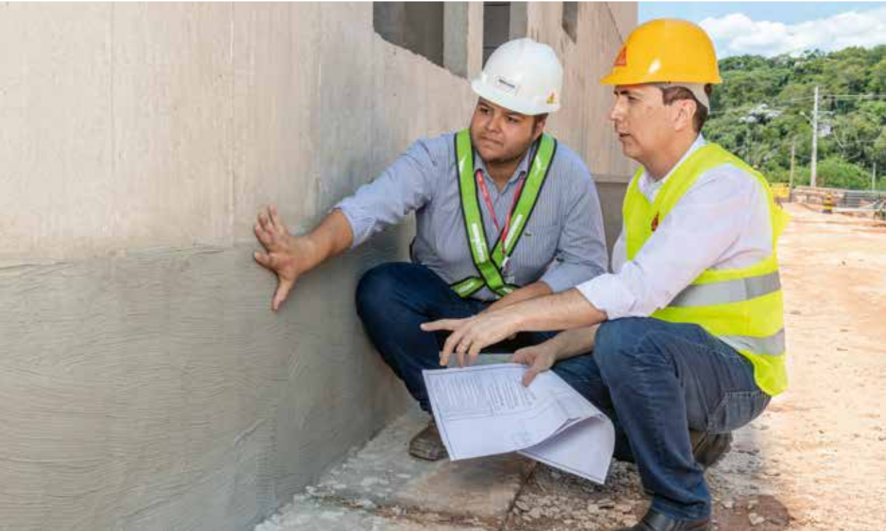
Zu Sikas Stärken gehört neben einem qualitativ hochwertigen Produktportfolio auch die Beratung des Kunden auf der Baustelle. Gemeinsam mit Direcional Engenharia wurden die besten Lösungen für die Projektanforderungen definiert und umgesetzt.
